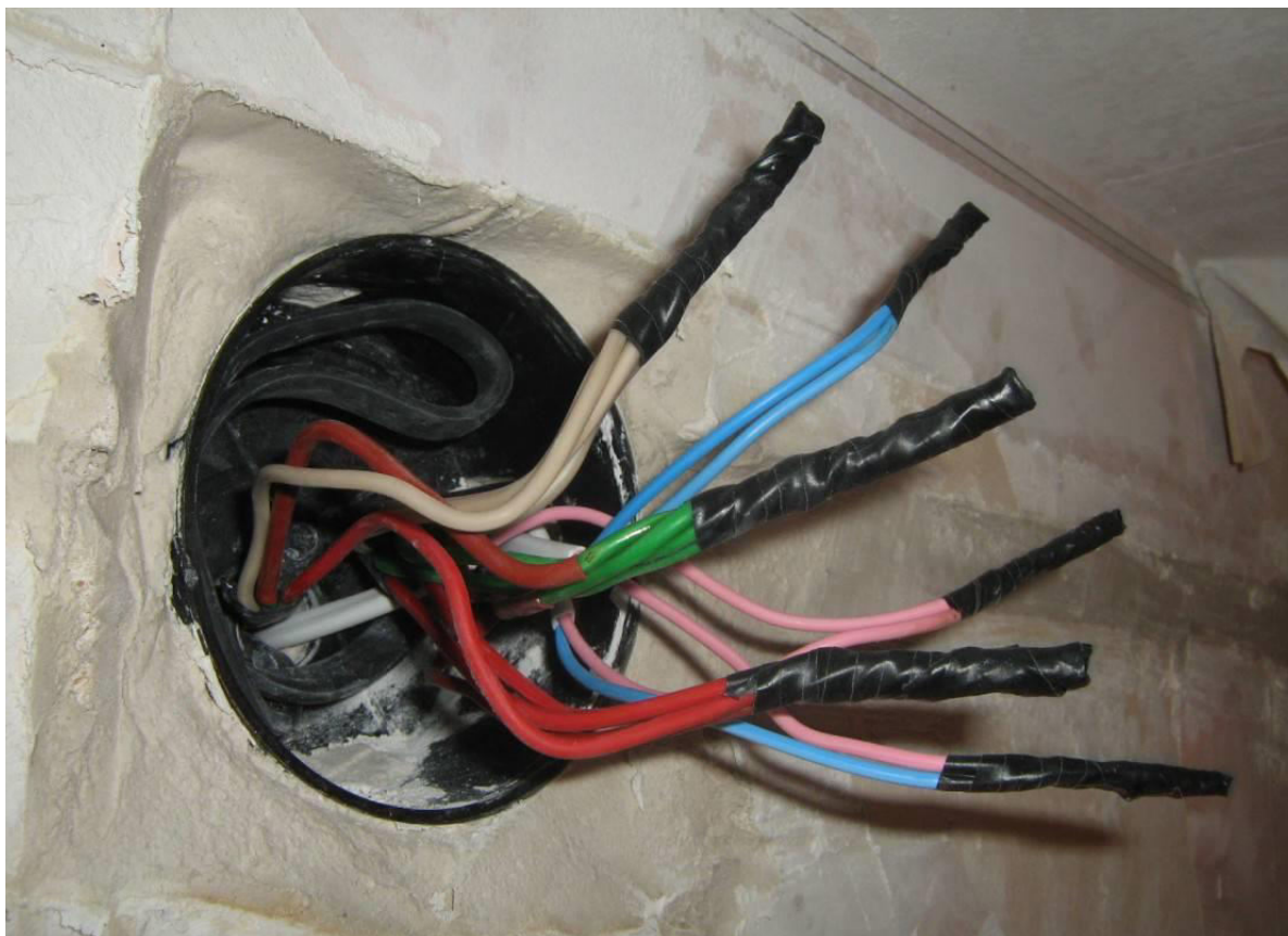
Мал. 28.10. Ізолювання з'єднаних проводів
