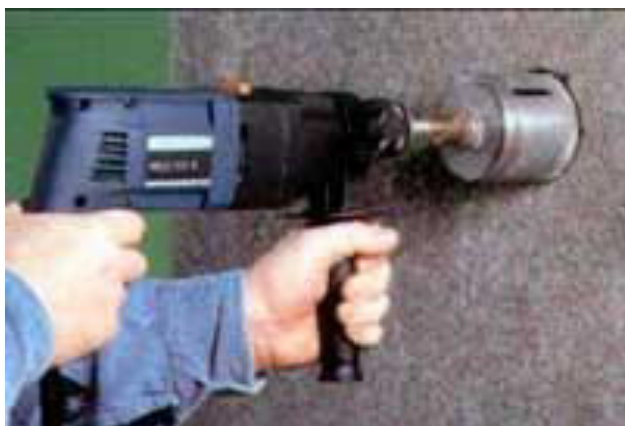
Мал. 43.4. Свердління посадочних місць під монтажні та розподільні коробки
