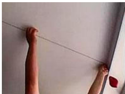
Мал. 43.2. Виконання розмітки відбивочним шнуром
