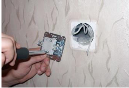
Мал.45.3. Встановлення вимикачів
