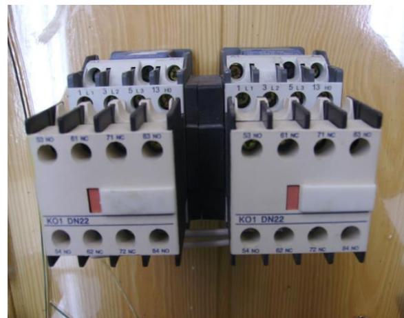
Мал. 53.3. Контактор малогабаритний для реверсивного пуску двигунів
