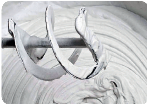
Рис. 7.27. Приготування шпаклівки за допомогою міксера
