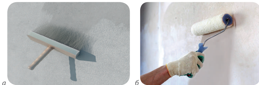
Рис. 7.24. Нанесення ґрунтівки: а – макловицею; б – валиком
