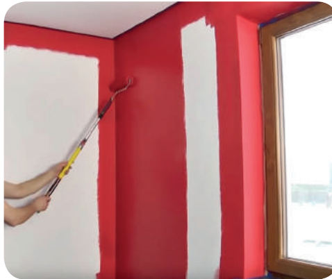
Рис. 7.45. Фарбування кожного фрагмента в одному й тому самому напрямку
