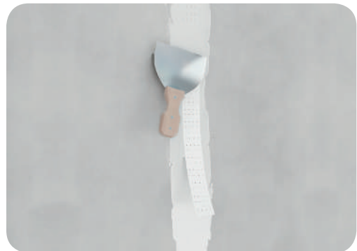
Рис. 7.19. Накладання паперової стрічки
