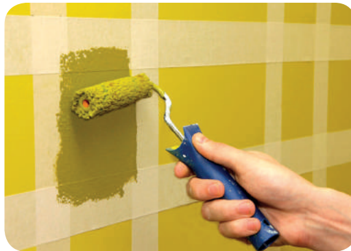
Рис. 7.47. Фарбування із застосуванням малярної стрічки
