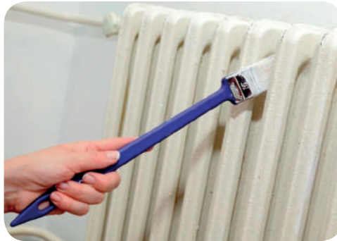
Рис. 7.51. Фарбування радіатора опалення
