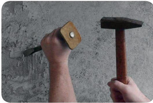
Рис. 8.4. Видалення наплівів з бетонної поверхні
