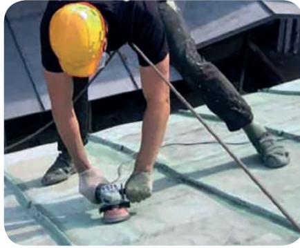
Рис. 8.10. Очищення металевої покрівлі
