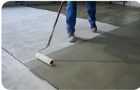
Рис. 7.7. Грунтування бетонної поверхні
