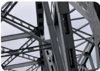
Рис. 5.17. Металева конструкція моста
