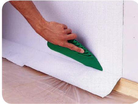
Рис. 7.34. Наклеювання шпалер
