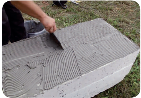
Рис. 9.10. Нанесення клейового розчину суцільним шаром (зубчастою гладилкою)
