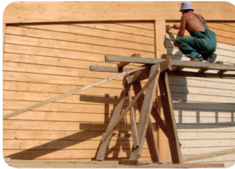
Рис. 8.9. Імпрегнування дерев'яного фасаду
