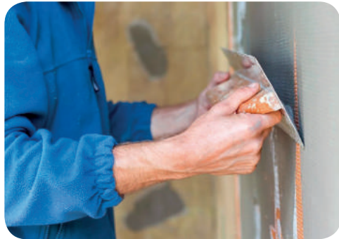
Рис. 9.18. Занурення армувальної сітки у клейовий розчин
