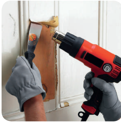
Рис. 7.2. Термічний спосіб очищення поверхні будівельним феном
