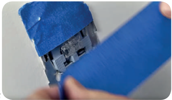
Рис. 7.41. Застосування малярної стрічки для захисту: а – віконної рами; б – розетки
