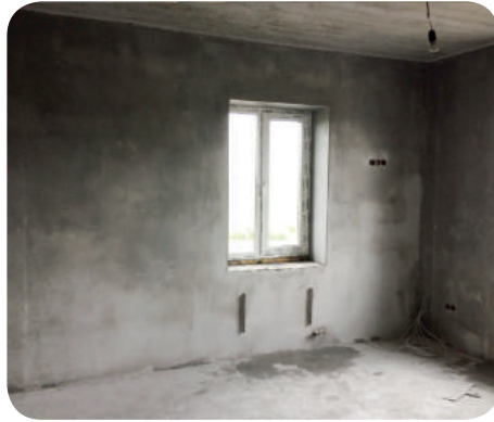
Рис. 7.10. Нова оштукатурена поверхня
