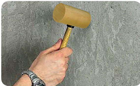
Рис. 8.6. Перевірка штукатурки на наявність відшарування
