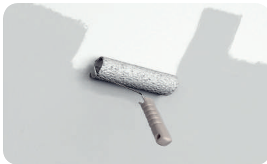
Рис. 7.23. Нанесення ґрунтувальної фарби
