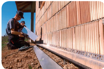
Рис. 9.8. Встановлення цокольного металевого профілю
