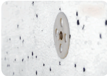
Рис. 9.14. Монтаж кріпильних дюбелів
