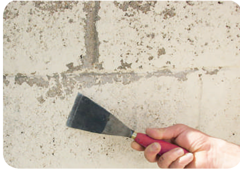
Рис. 8.7. Очищення поверхні фасаду за допомогою шпателя
