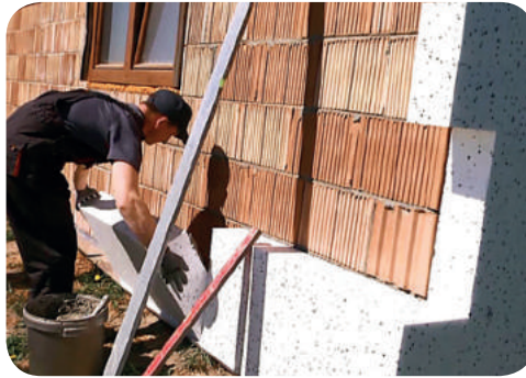
Рис. 9.11. Приклеювання теплоізоляційних плит
