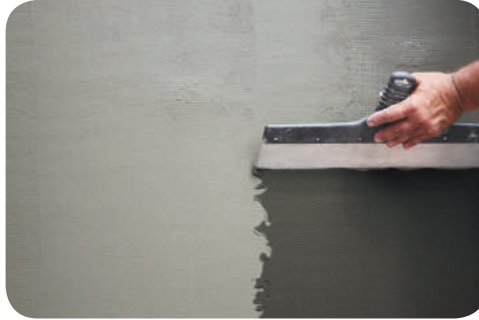
Рис. 9.19. Вирівнювання армованого шару
