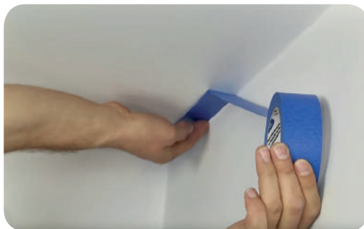
Рис. 7.42. Розмежування поверхонь за допомогою малярної стрічки
