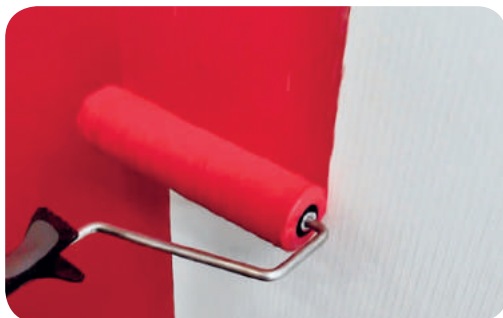
Рис. 7.48. Фарбування шпалер за допомогою валика
