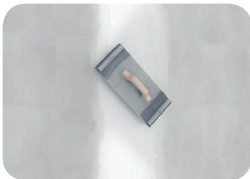
Рис. 7.21. Шліфування
