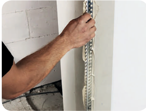
Рис. 7.25. Монтаж алюмінієвого профілю на кут стіни
