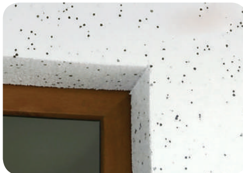
Рис. 9.12. Кріплення теплоізоляційних плит на куті фасадного отвору
