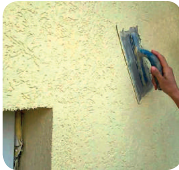
Рис. 9.21. Нанесення штукатурки за допомогою терки
