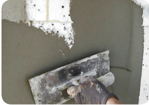
Рис. 9.17. Нанесення клейового розчину
