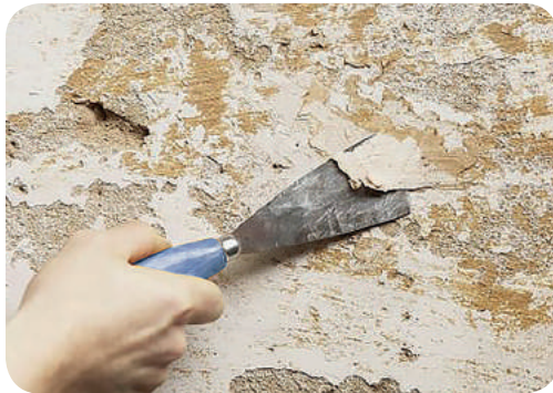
Рис. 7.12. Усунення штукатурного шару, пошкодженого грибком
