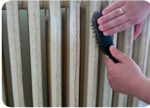
Рис. 7.39. Очищення радіатора опалення за допомогою металевої щітки
