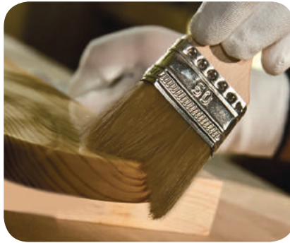
Рис. 7.35. Нанесення ґрунтівки на дерев'яну поверхню
