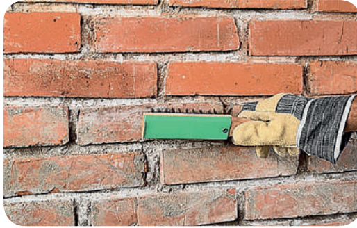
Рис. 7.9. Висоли на цегляній поверхні
