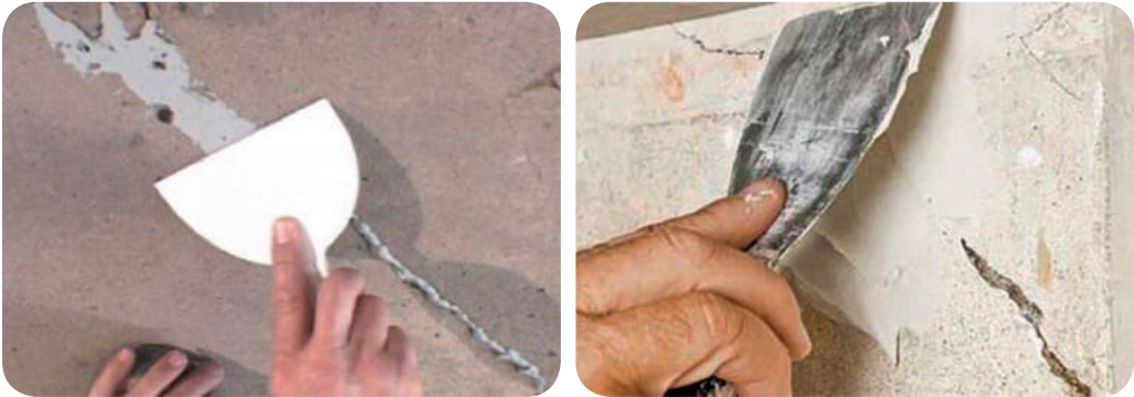
Рис. 8.3. Шпаклювання тріщин на фасаді
