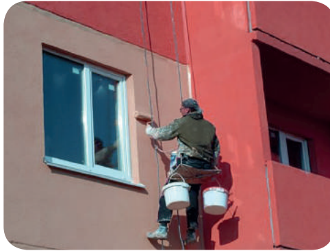
Рис. 8.15. Фарбування фасаду валиком
