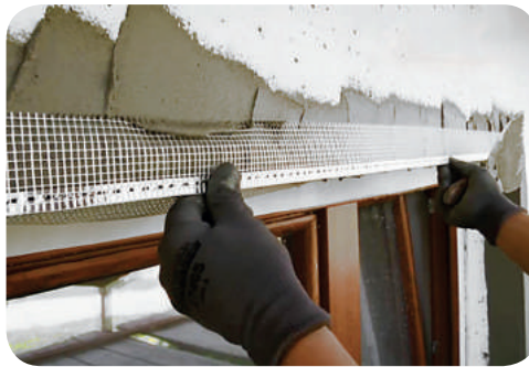
Рис. 9.15. Накладання кутника під армувальну сітку
