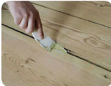
Рис. 7.36. Шпаклювання тріщин на дерев'яній поверхні
