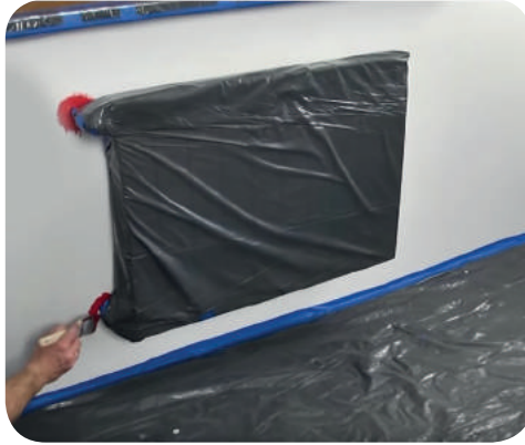
Рис. 7.44. Фарбування важкодоступних місць
