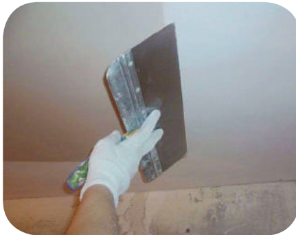
Рис. 7.29. Фінішне шпаклювання стелі за допомогою шпателя
