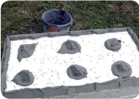
Рис. 9.9. Нанесення клейового розчину «коржичиками»
