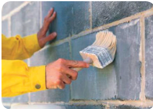
Рис. 8.2. Ґрунтування поверхні фасаду
