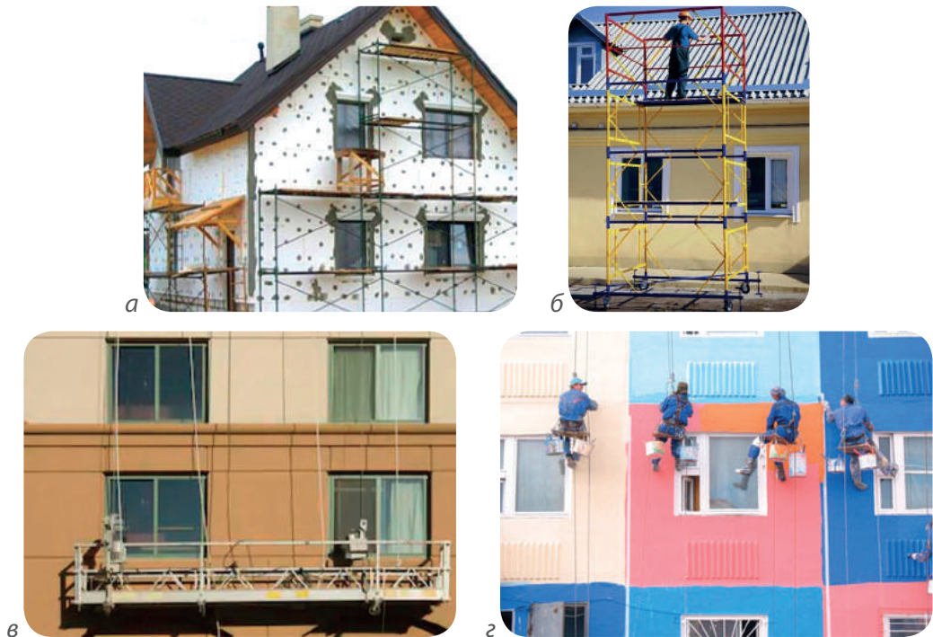
Рис. 8.13. Засоби підмоцвання: а – риштування; б – пересувна вишка; в – колиска будівельна; г – верхолазне спорядження
