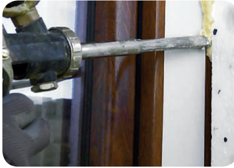
Рис. 9.13. Заповнення щілин між плитами поліуретановою піною
