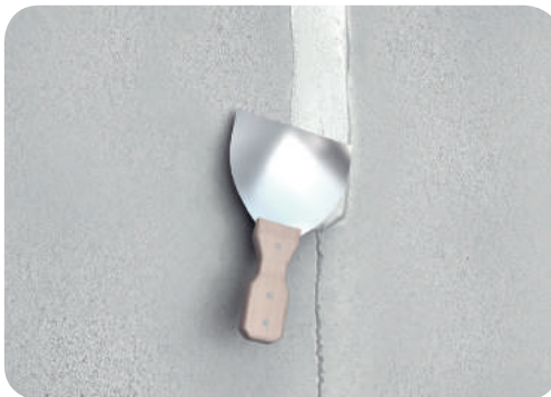
Рис. 7.18. Нанесення шару шпаклівки
