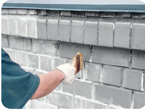
Рис. 8.5. Ґрунтування силікатної цегли
