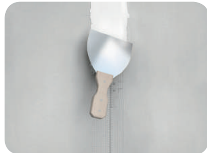
Рис. 7.17. Нанесення шпаклівки на стрічку зі скловолна
