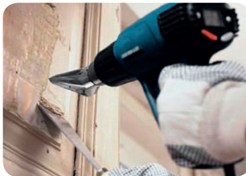
Рис. 7.37. Очищення дерев'яної поверхні від лакофарбового покриття за допомогою будівельного фена
