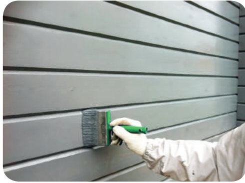
Рис. 8.16. Фарбування дерев'яного фасаду
